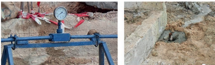
Photo 11.03-3. Manomètre de contrôle de pression et micropieu achevé
