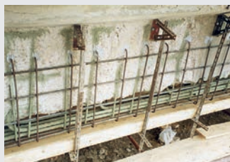
Fiche 10.02 Renforcement par béton rapporté (chemisage)
