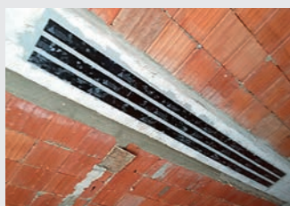
Fiche 10.04 Renforcement par lamelles en fibres de carbone
