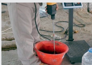
Fiche 8.04 Préparation et mise en œuvre des produits à base de liants
