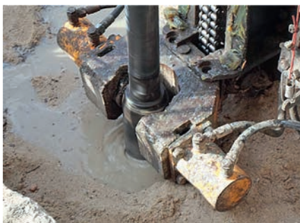
Photo 11.03-2. Opération de forage et tube d'injection
