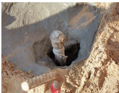
Photo 11.03-2. Opération de forage et tube d'injection
