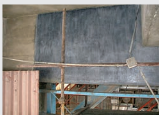
Fiche 10.05 Renforcement par tissu en fibres de carbone
