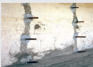
Fiche 9.04 Traitement des fissures et joints
