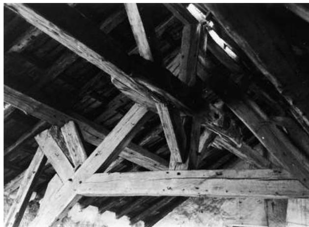
**Photo 4.3. Contreventement longitudinal de ferme**
