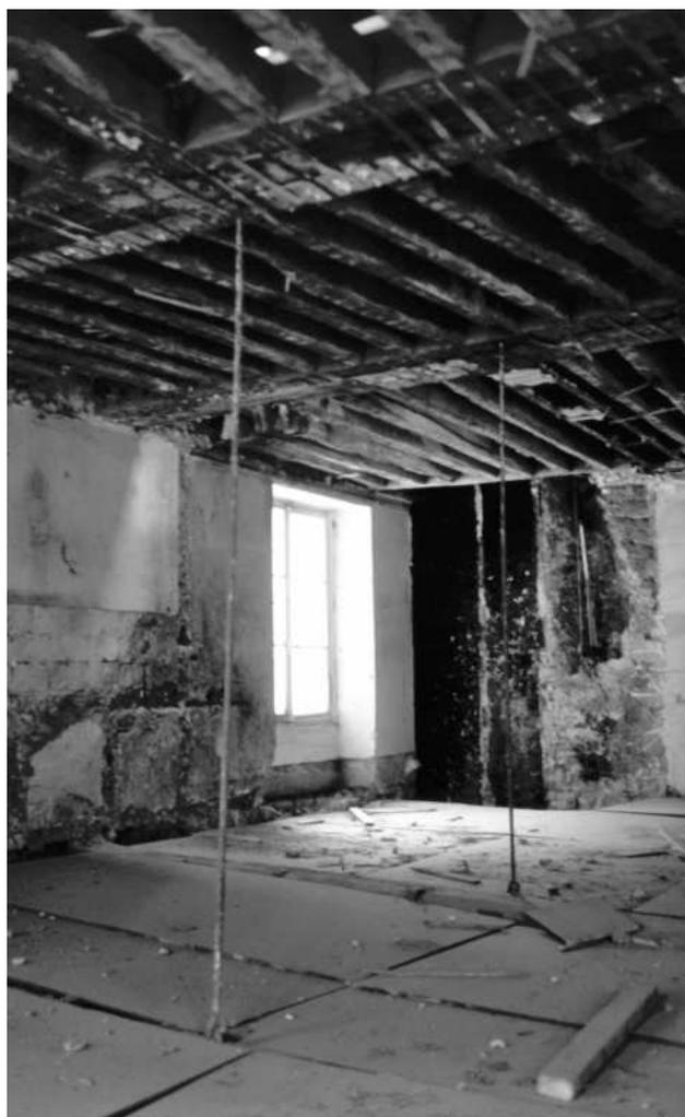
**Photo 4.6. Aiguilles pendantes suspendues aux poinçons de fermes à entrails moisants portant plancher**
