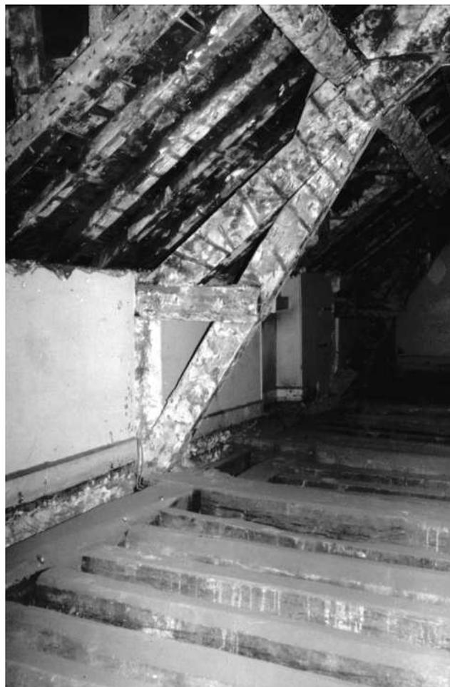
**Photo 4.12. Entrain retroussé en appui sur un plancher à système d'enchevêtrements (milieu du XIX<sup>e</sup> siècle)**
