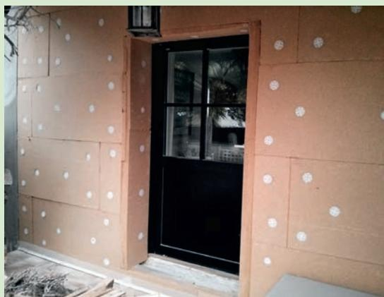
**Photo 11.3 Remplacement de l'ancienne baie vitrage en double vitrage par une nouvelle porte d'entrée en triple vitrage (Internorm HF310). Isolation extérieure de l'entrée en fibre de bois (8 cm) avant la pose de l'enduit**
