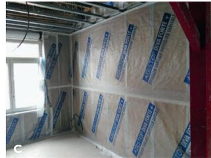
**Photo 3.7 L'isolation par l'intérieur en laine de mouton : pose du frein-vapeur hydrovariable**
