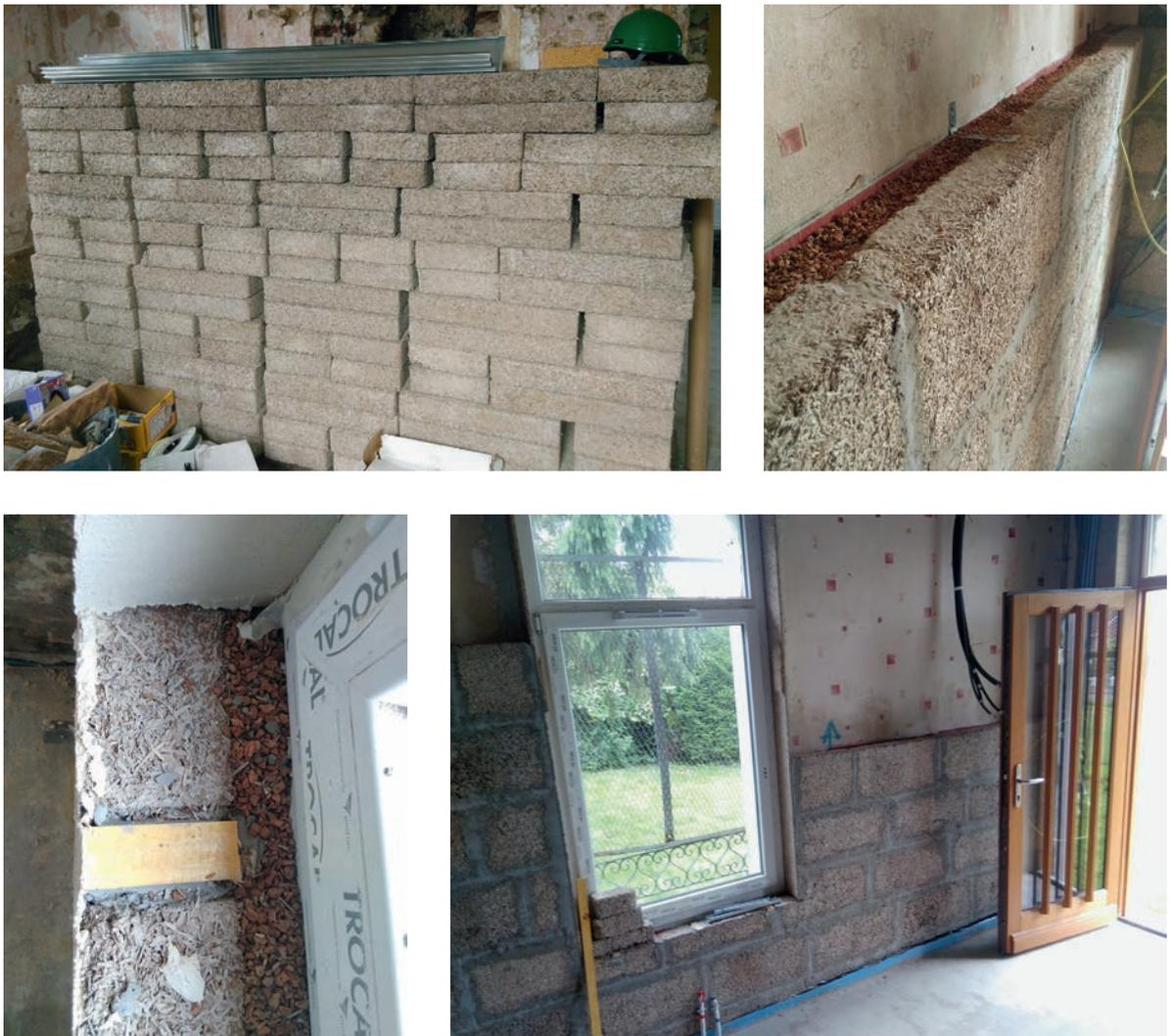
**Photo 3.4 Isolation par l'intérieur à l'aide de blocs de chanvre**
