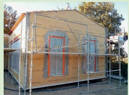
**Photo 11.8 Les menuiseries sont en triple vitrage**
