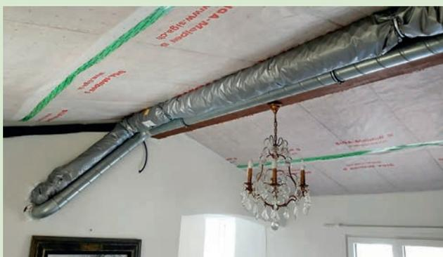
**Photo 11.5 Pose du pare-vapeur dans l'entrée ; étanchéité à l'air de l'existant au niveau du plâtre intérieur des murs et liaison avec le pare-vapeur par scotch Siga Fentrim 20**
