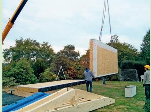
**Photo 11.6 Une dalle en lamellé collé posée sur pieux Technopieux vissés dans le sol**
