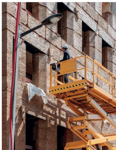
**Pose de blocs de pisé préfabriqués en façade d'un bâtiment**
