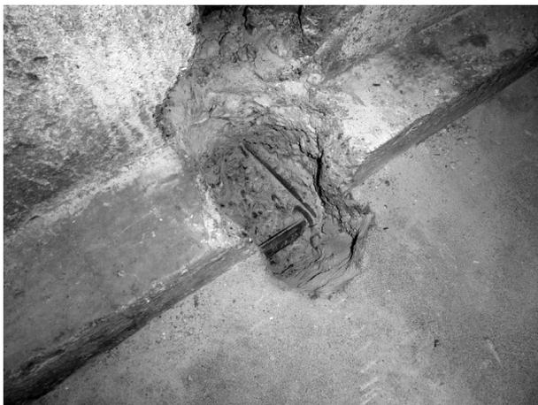
**Photo 2.3.** Exemple de sondage destructif
