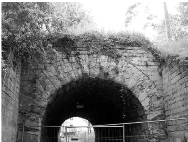
Photo 7.19. Vue générale de l'ouvrage
