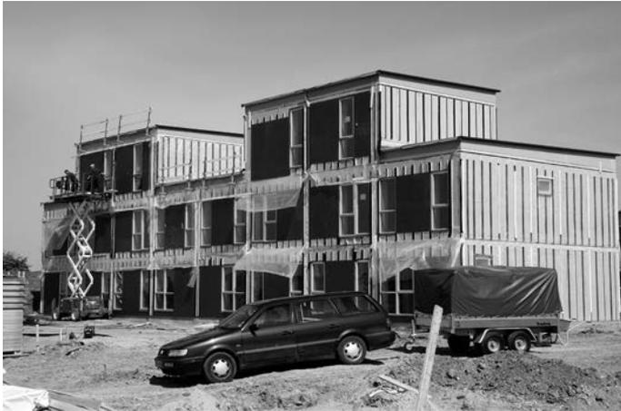
Photo 11.3. Assemblage sur site des éléments préfabriqués (source : projet Class 1)
