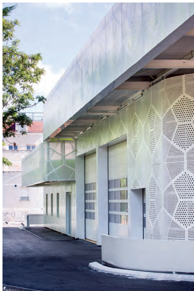
Une résille métallique blanche aux contours arrondis enveloppe la structure poteaux-poutres en acier.
