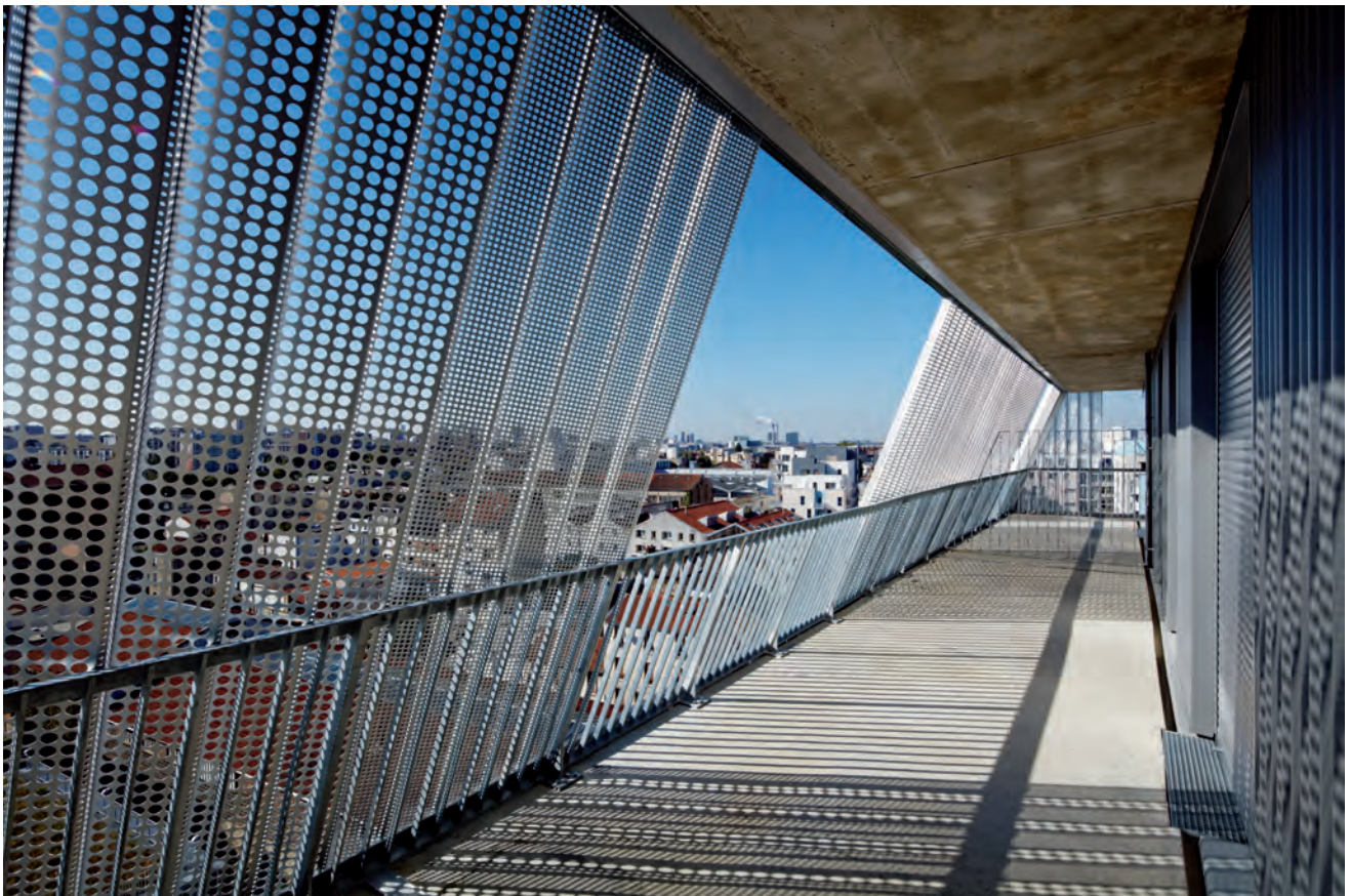
Derrière le voile métallique, les balcons filants de la résidence étudiante.
