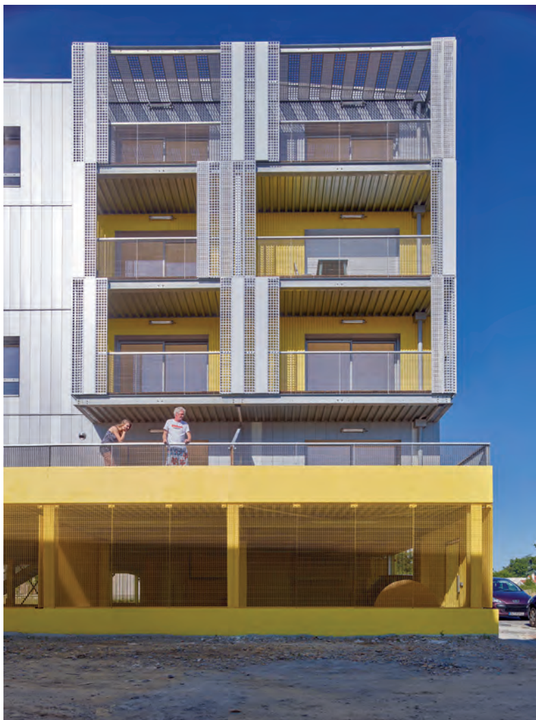
Chaque façade est dotée d'espaces extérieurs logés dans l'épaisseur de la double peau : ici les balcons.
