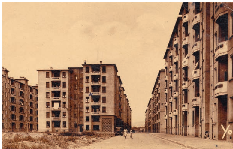
Photo 3.75. Immeubles de la rue des Serpollières, vers 1936
