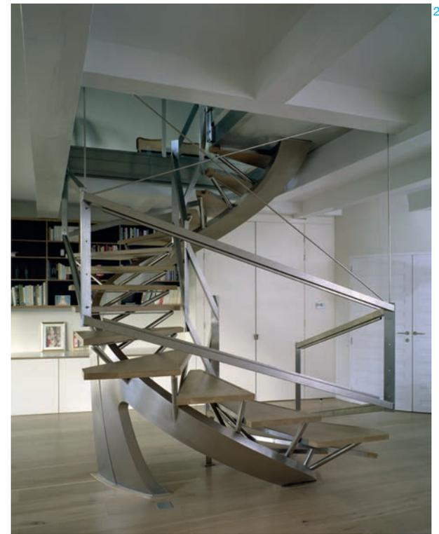
4 La rampe est suspendue par des fils d'acier.
