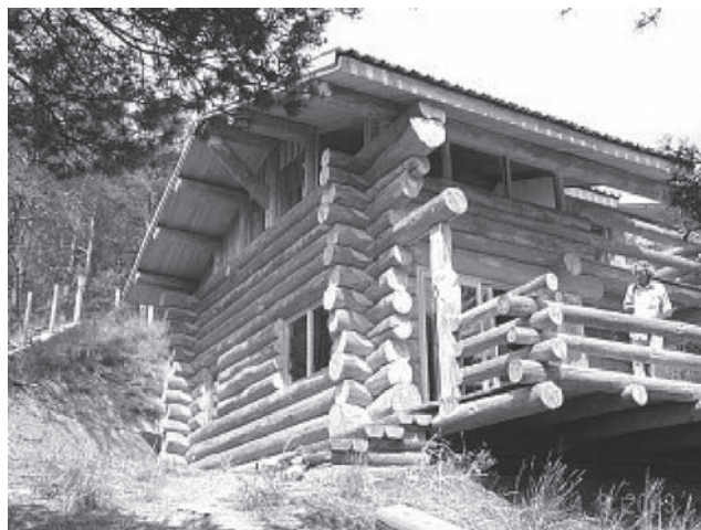
Photo 2.4. Mur en grumes empilées ou fustes
