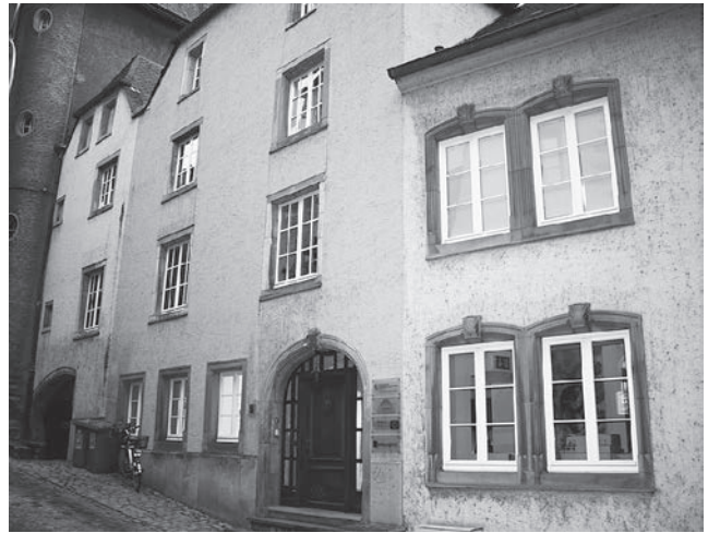
Photo 2.2. Bâtiment en pierres enduites
