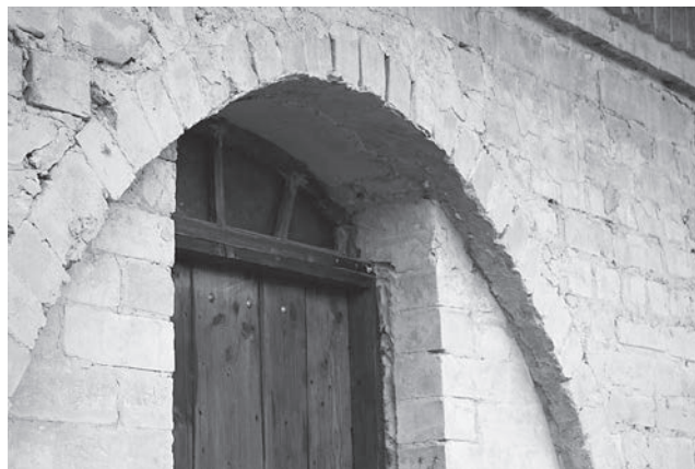
Photo. 2.1. Bâtiment en briques de terre crue
