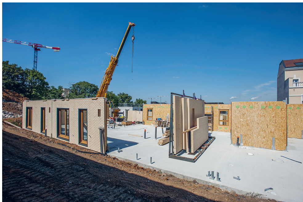
Photo 6.5. Éléments préfabriqués posés et en attente de pose (photo : © Bruno Barjhoux)
