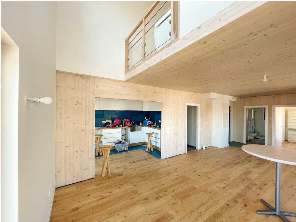
Photo 6.4. Usage du CLT en murs de refends et planchers intermédiaires des duplex (photo : © Claire Bordat)
