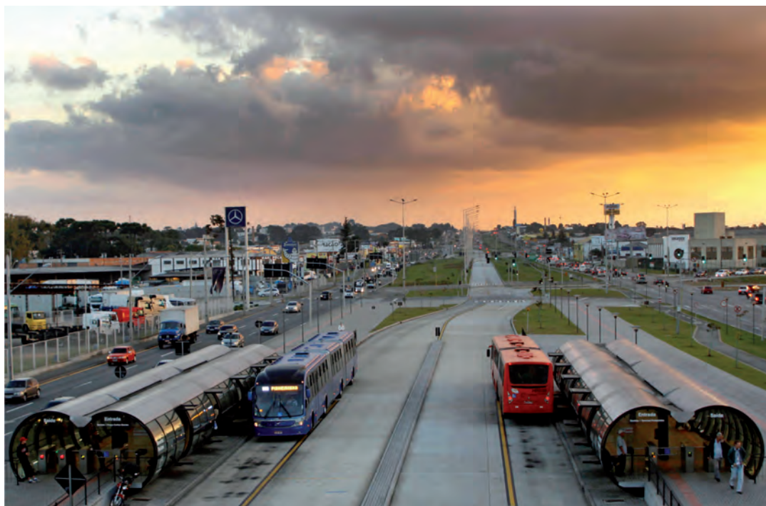
Curitiba, système de bus en réseaux : terminaux urbains.
