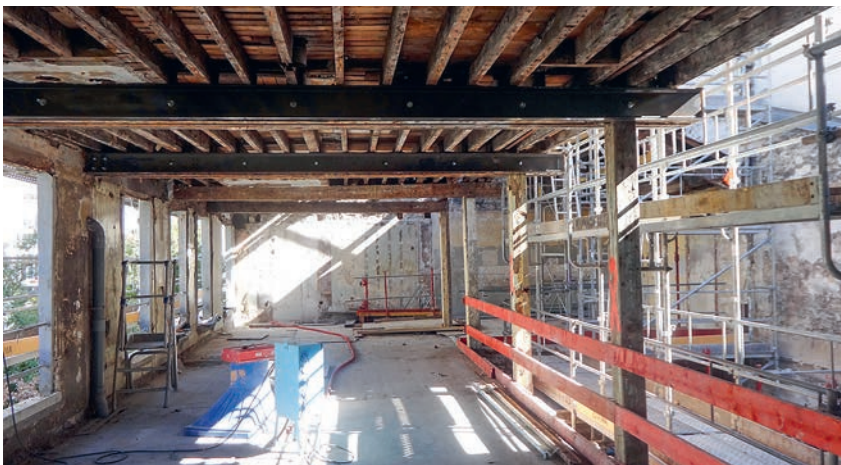
Photo 4. Chantier Brûlon, Paris, MOA : RIVP, Architectes : DJM.
