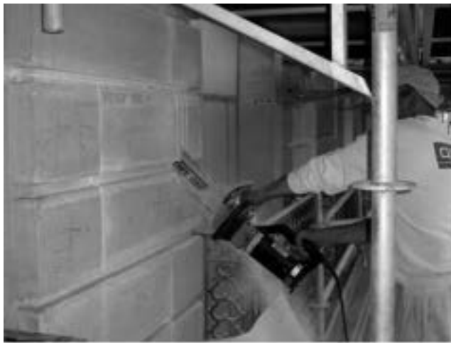
Sciage du logement
