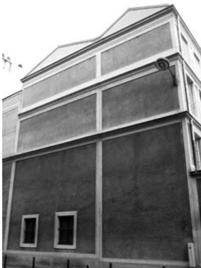
Photo 5.21. Façade homogène enduite au crépis tyrolien
