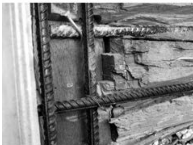
Renforcement par armatures métalliques
