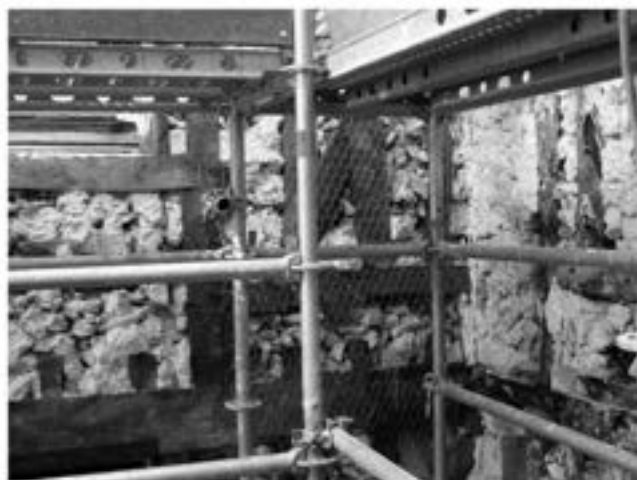
Les pièces de bois sont recouvertes d'un feutre avant enduisage (DTU 26.1)
