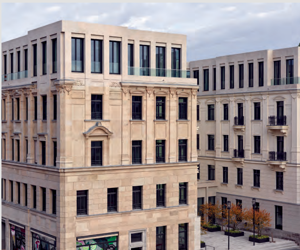
↑ Photo 11.26. Palais Wiesbaden, Allemagne, par Max Dudler Architekt, 2020. © Stefan Müller.
