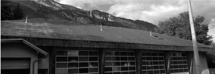
**Photo 5.18. Toiture comprenant des cheminées, un puits de lumière et des chatières, avant les travaux photovoltaïques** (source : Cythelia Energy)
