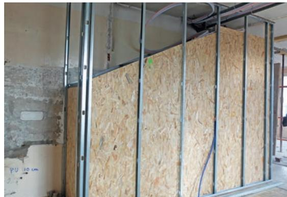
▲ Fig. 6.4. Préparation de la cage d'escalier pour recevoir 20 cm de mousse de PU projetée (Crédit photo : Pierre Leriche)
