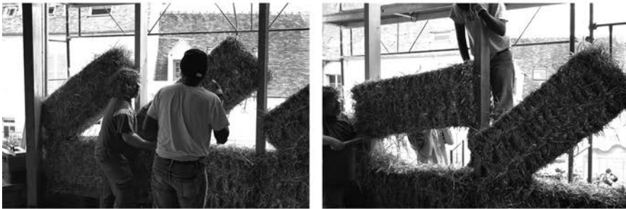
Intégration par basculement en diagonale
