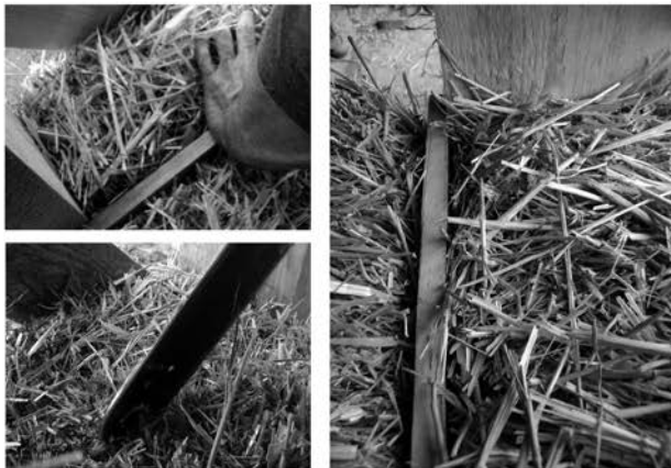
Intégration d'un liteau dans une entaille
