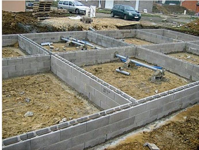
Photo 2.2. Mur de soubassement en blocs à bancher
