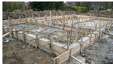
Photo 2.1. Mur de soubassement en béton armé coulé dans des coffrages
