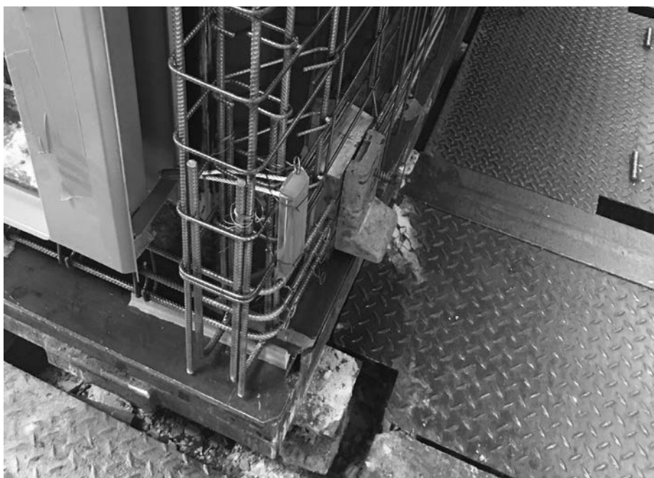
Photo 10.6. Chaînage vertical d'extrémité
