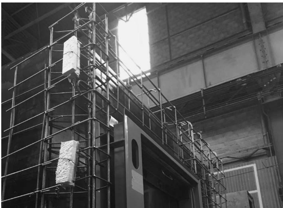
Photo 10.8. Chaînages verticaux et horizontaux autour d'une ouverture
