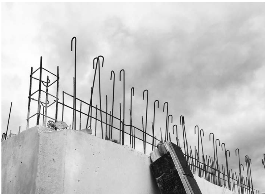
Photo 10.5. Attente de voiles de reprise d'étage et chaînage
