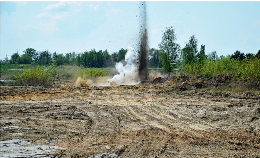
Photo 6.1. Vue d'un chantier de compactage à l'explosif au moment du tir, Gdansk – Pologne
